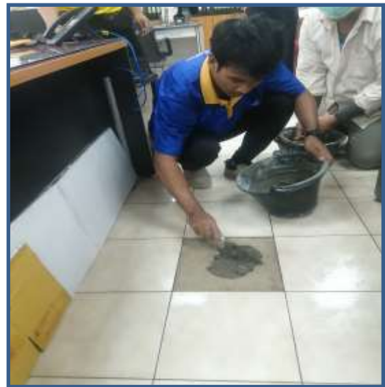
2. นำปูนขาวลงบริเวณปูกระเบื้อง
